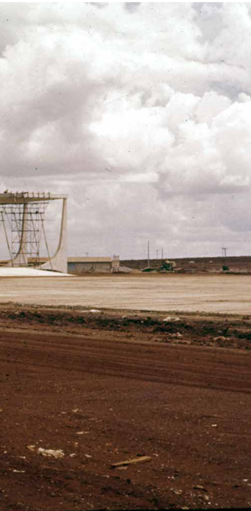
Construção STF - Brasília/DF - 1956/1960
