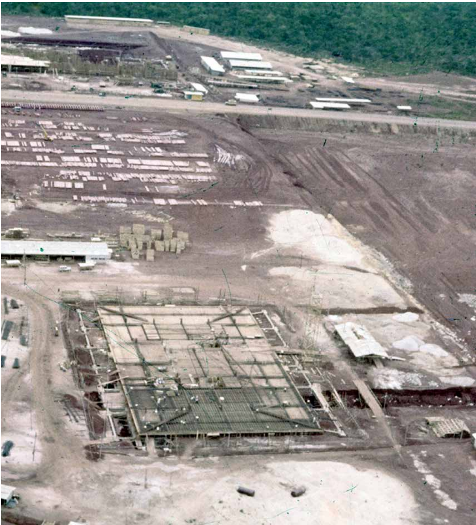
Construção STF - Brasília/DF - 1956/1960
